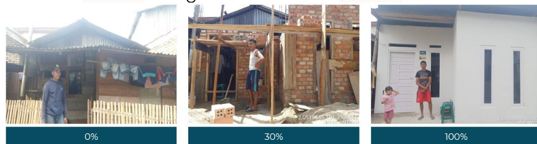
Gambar 41. Progres BSPS di Perkotaan 2
