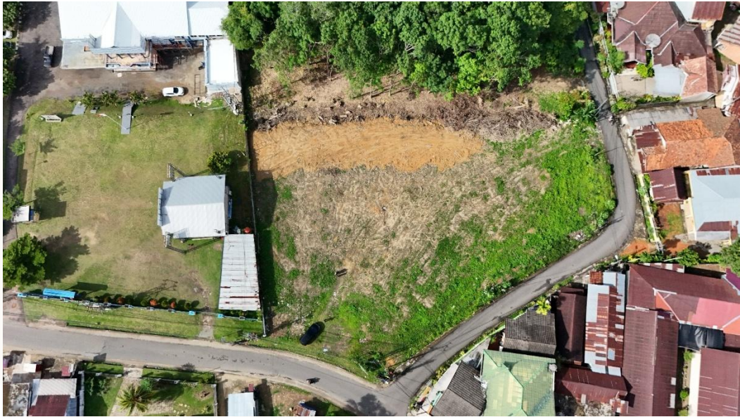
Gambar 43. Lokasi Rusun dari atas setelah pembersihan lahan
