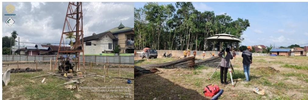
Gambar 3.3.1. 4 Dokumentasi Pembangunan Rumah Susun (Rusun) Mahkamah Agung Republik Indonesia (MA RI) di Provinsi Jambi
