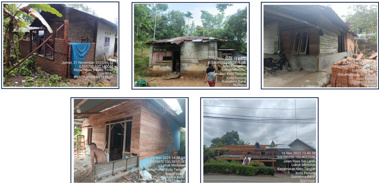
Gambar II-6 : Dokumentasi Pelaksanaan Kontruksi Pembangunan BSPS Perumahan Perkotaan Kota Padang Provinsi Sumatera Barat Tahun 2025
