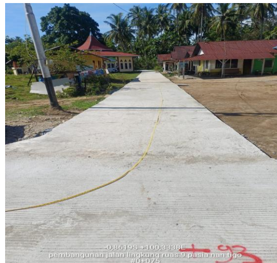
Pekerjaan Jalan Beton
