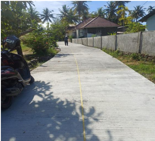
Pekerjaan Jalan Beton
