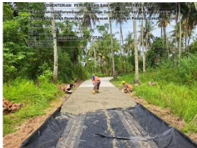
Pek. Jalan Rabat Beton*
