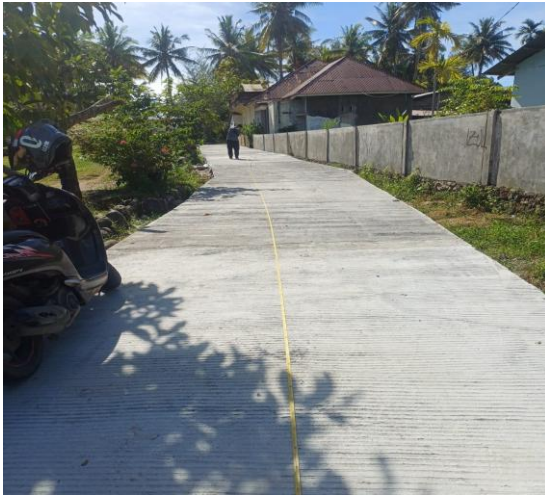
Pekerjaan Jalan Beton
