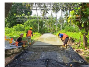
Pek. Jalan Rabat Beton*
