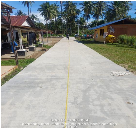
Pekerjaan Jalan Beton
