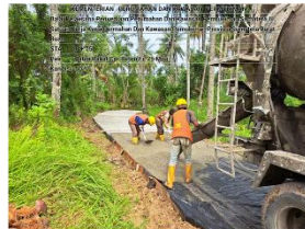
Pek. Jalan Rabat Beton*
