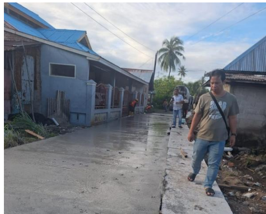
Pekerjaan U-ditch dan Jalan
