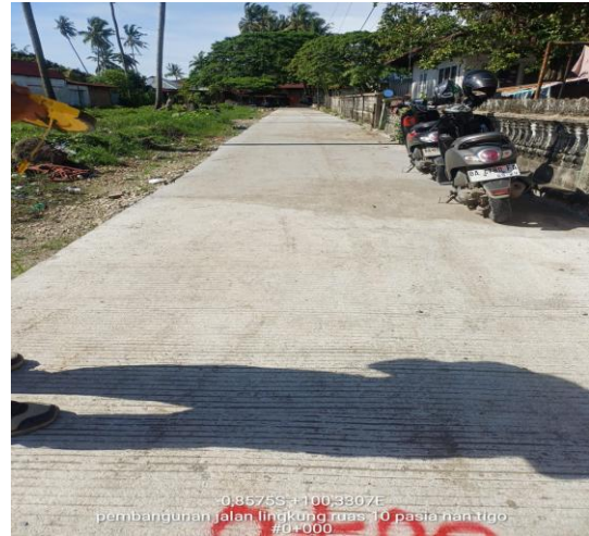
Pekerjaan Jalan Beton
