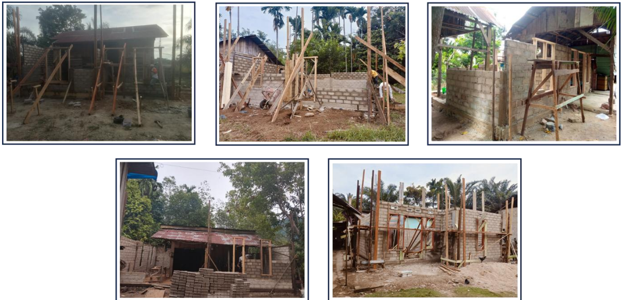
Gambar II-5 : Dokumentasi Pelaksanaan Kontruksi Pembangunan BSPS Perumahan Perdesaan Kabupaten Dharmasraya Sumatera Barat Tahun 2025
