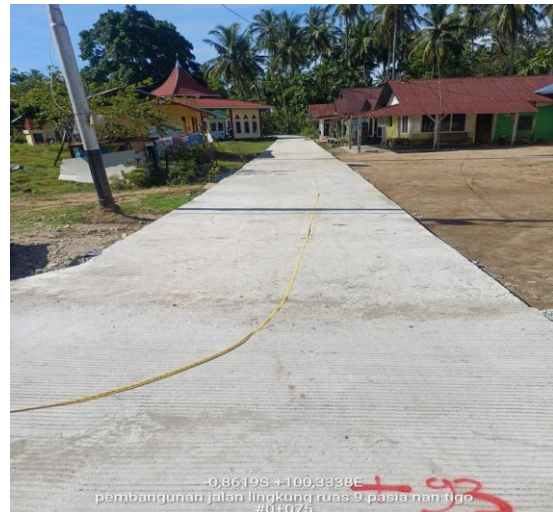
Pekerjaan Jalan Beton
