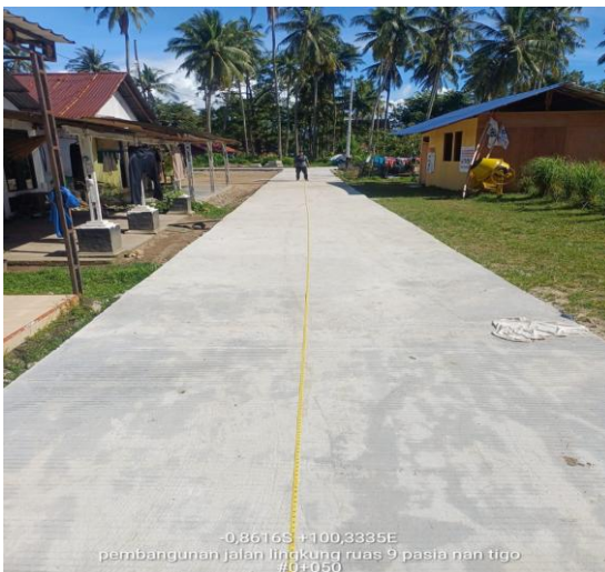
Pekerjaan Jalan Beton
