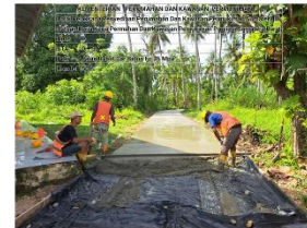
Pek. Jalan Rabat Beton*
