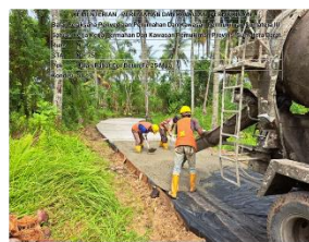
Pek. Jalan Rabat Beton*
