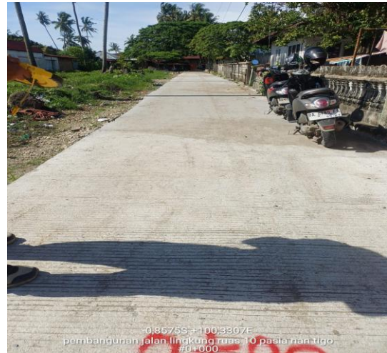
Pekerjaan Jalan Beton
