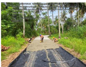
Pek. Jalan Rabat Beton*
