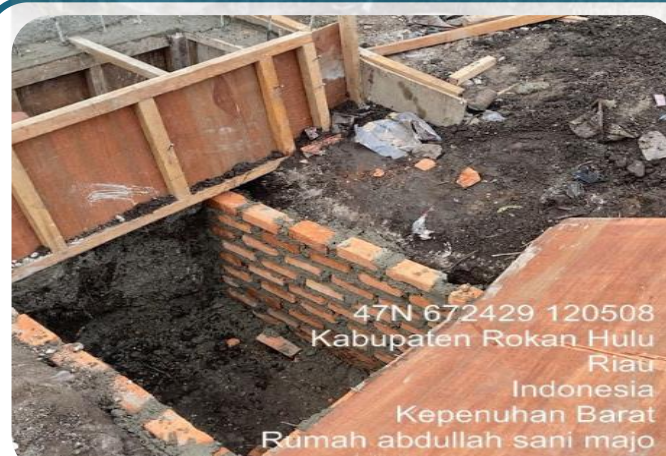
Pek. Pembuatan Sumur Resapan
