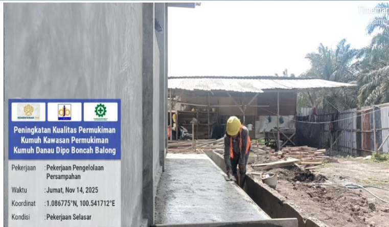
Pekerjaan Acian Saluran Keliling
