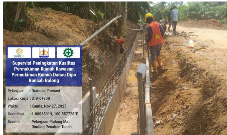
Pekerjaan pada Mal DPT
