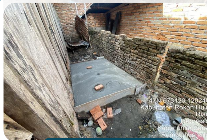
Pek. Pembuatan Septictank
