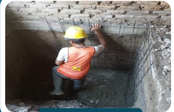
Pek. Pembuatan Septictank
