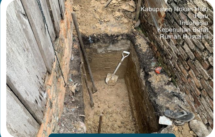
Pek. Pembuatan Septictank
