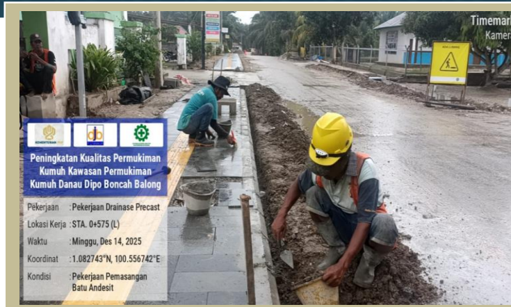
Pekerjaan Pemasangan Batu Andesit
