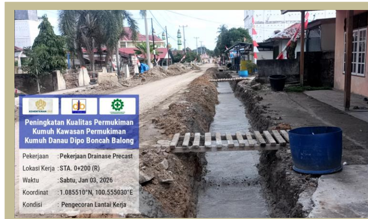
Pek. Pengecoran Lantai Kerja
