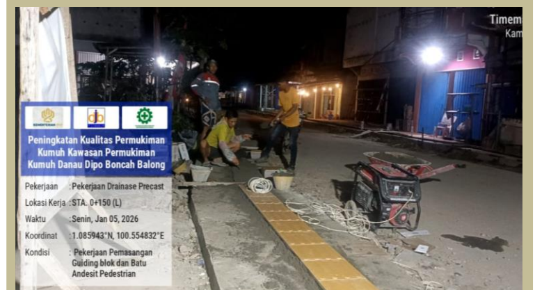
Pek. Pas. Batu Andesit dan Guiding Block STA 0+150 (L)
