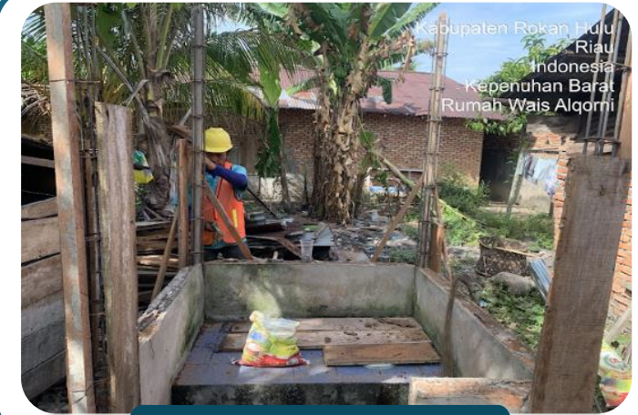
Pembongkaran bilik eksisting
