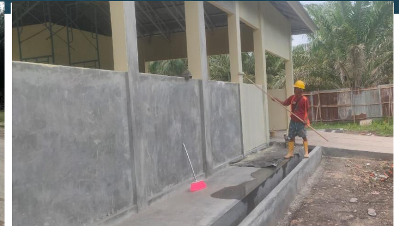
Pengecatan pada Bangunan TPS-3R
