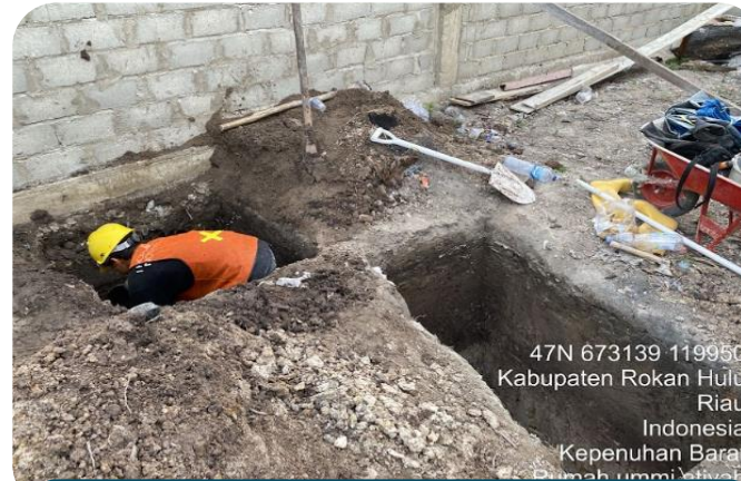
Pek. galian septictank dan sumur resapan
