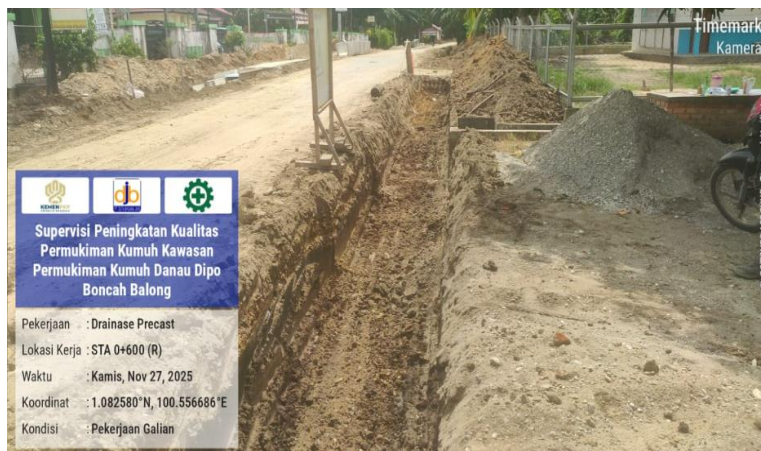
Pekerjaan Galian STA 0+600 (R)
