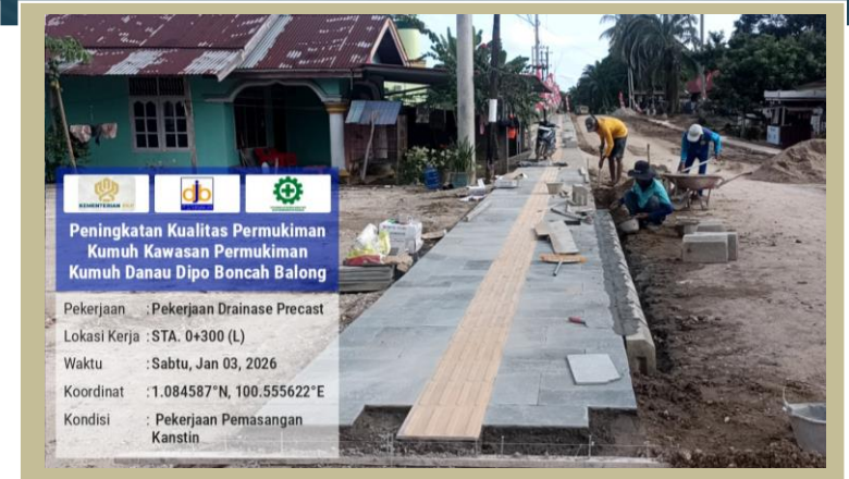
Pekerjaan Pemasangan Kanstin STA 0+300
