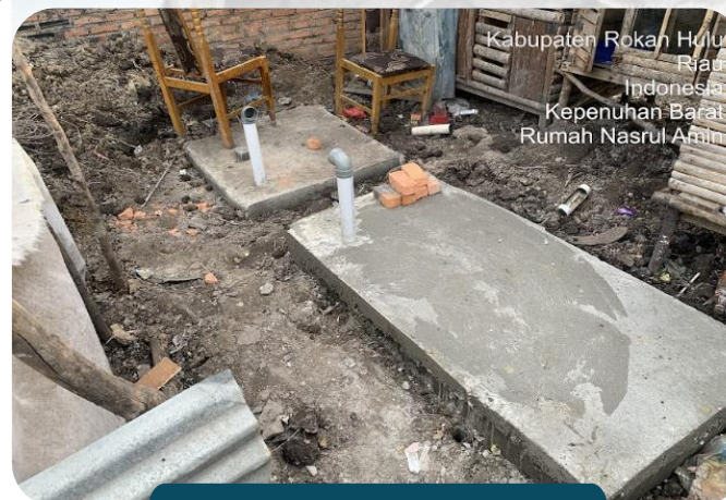
Pek. Pembuatan Septictank
