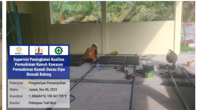
Pekerjaan Trali Besi pada Bangunan TPS-3R
