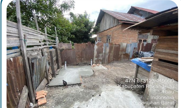
Pek. Pembuatan Septictank
