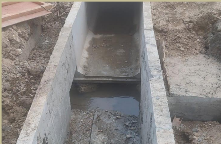
Rencana sumur resapan sisi kiri STA 0+325 dan bak control 80x80 cm
