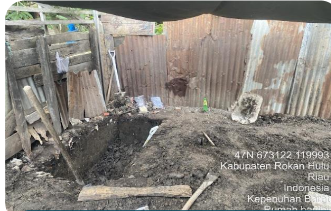
Pek. galian septictank dan sumur resapan
