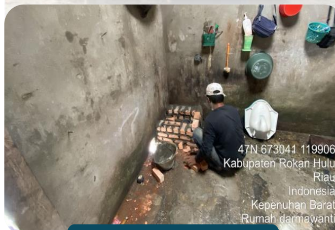
Pek. Pemasangan Kloset
