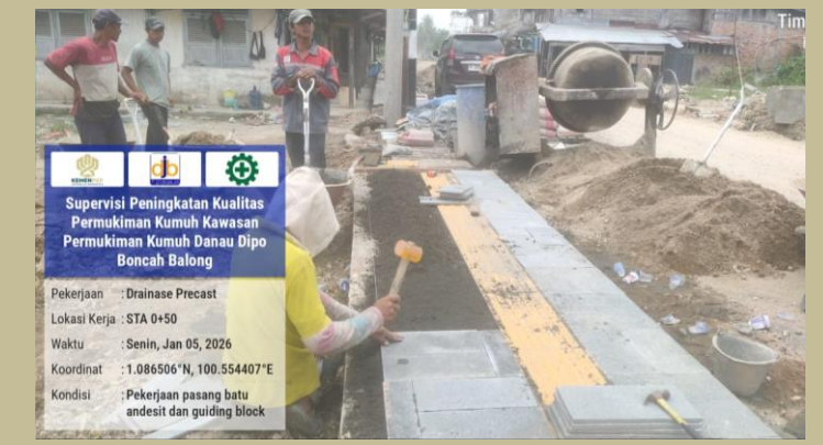
Pek. Pas. Batu Andesit dan Guiding Block STA 0+50 dan 0+250
