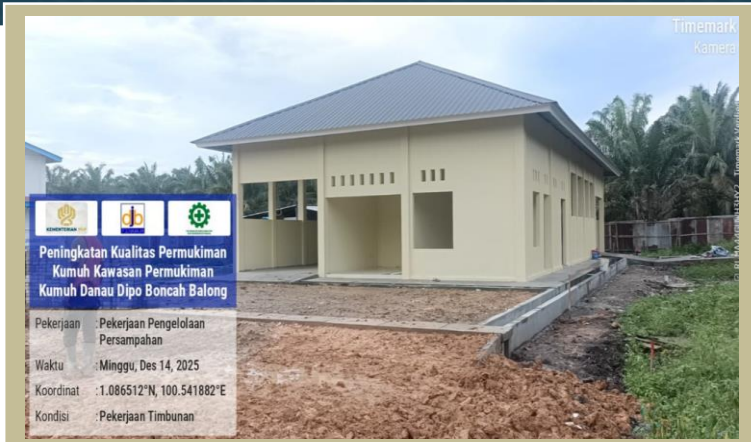
Pekerjaan Bangunan TPS-3R
