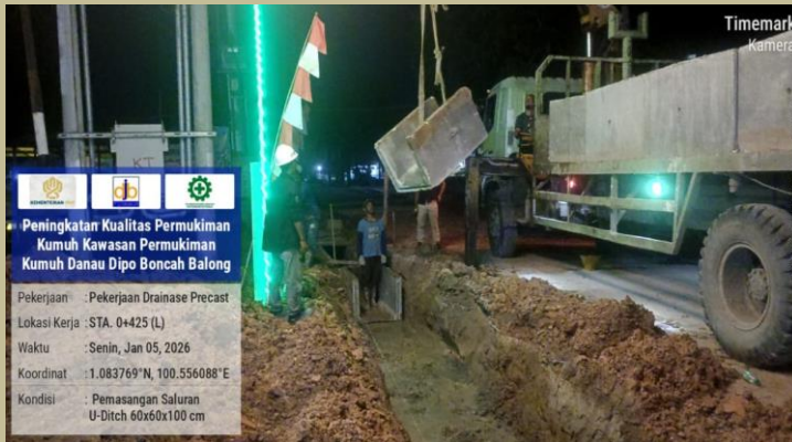
Pemasangan saluran U-Ditch STA 0+425 (L)
