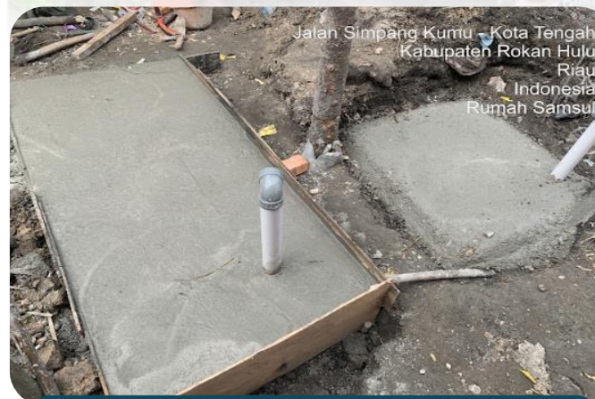
Pek. Penutup Sumur Resapan dan Septictank
