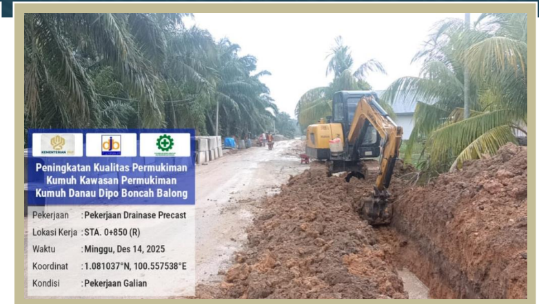
Pekerjaan Galian pada STA 0+850
