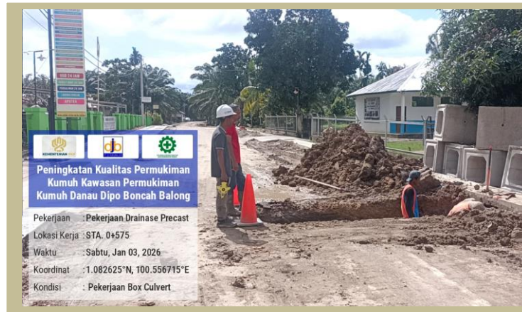
Pek. Pemasangan Box Culvert STA 0+575
