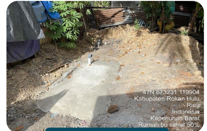
Pek. Pembuatan Septictank
