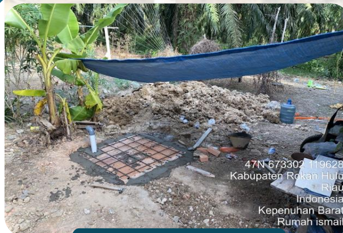
Pek. Pembuatan Sumur Res.
