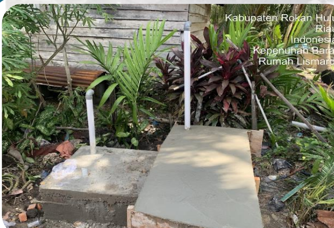
Pek. Pembuatan Sumur Resapan dan Septictank
