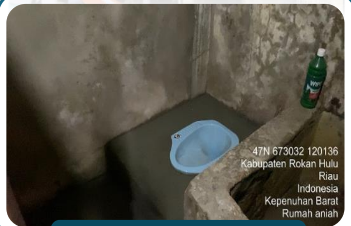
Pekerjaan Pemasangan Kloset
