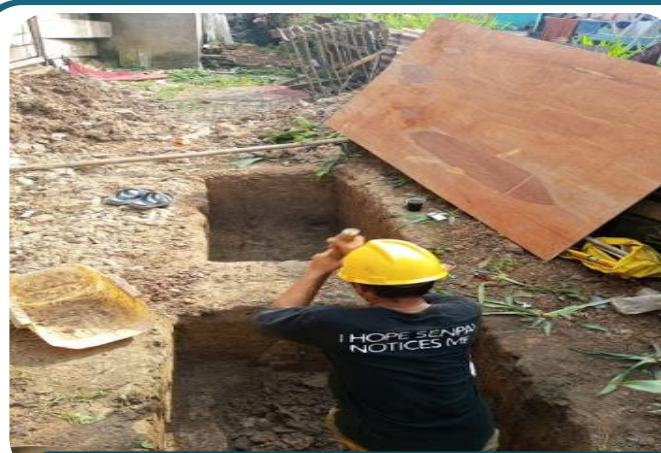
Pek. galian septictank dan sumur resapan
