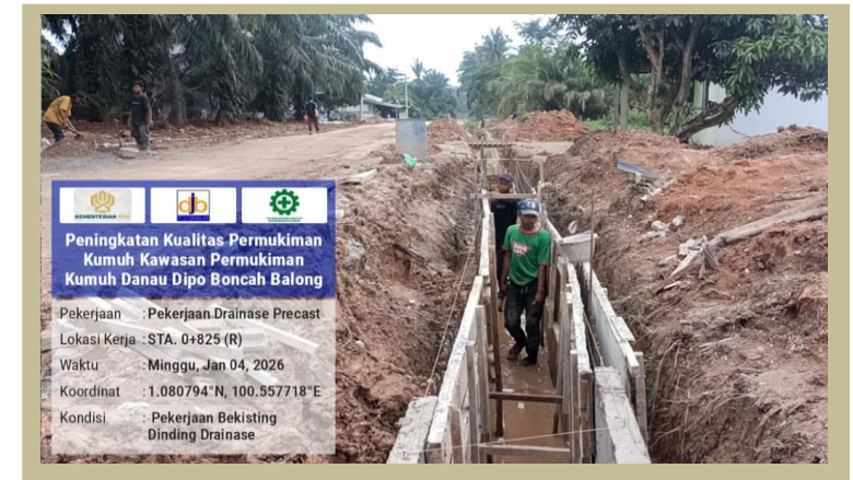
Pek. Bekisting Dinding Saluran STA 0+825(R)
