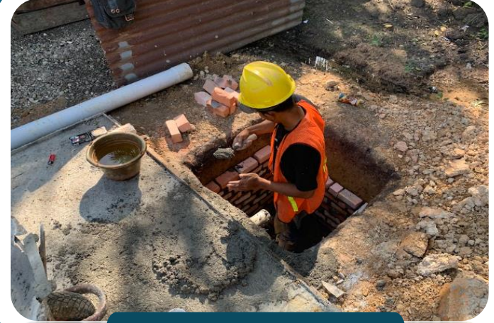
Pek. Pembuatan Sumur Res.
