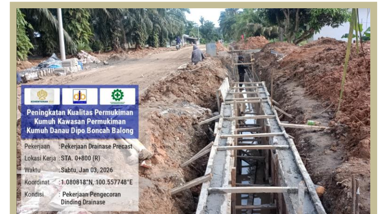
Pek. Pengecoran pada Dinding Saluran
