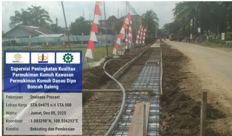
Pembesian dan Bekisting Cover U Ditch STA 0+475 s.d 0+500
