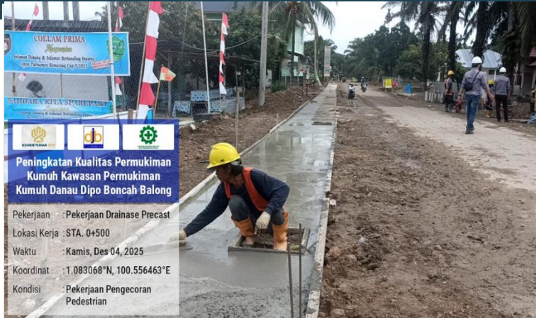
Pekerjaan Pengecoran Pedestrian
