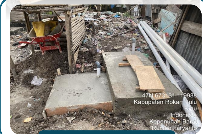
Pek. Pembuatan Sumur Resapan
