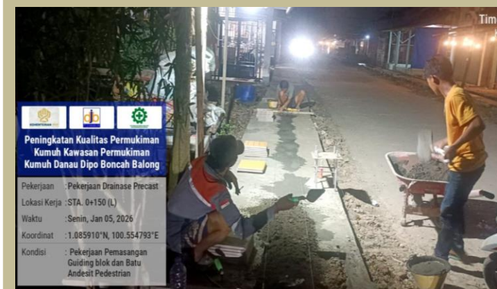
Pek. Pas. Batu Andesit dan Guiding Block STA 0+150 (L)
