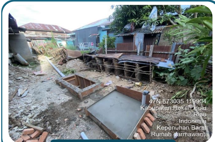
Pek. Pembuatan Septictank
