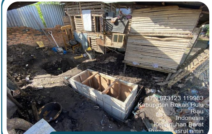
Pek. Pembuatan Septictank
