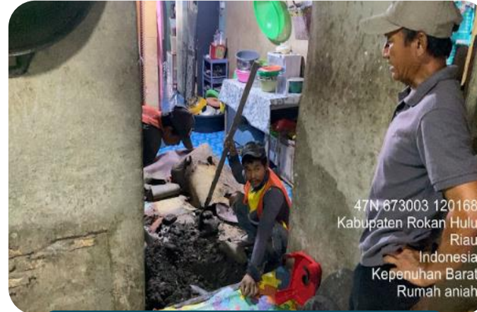
Pekerjaan Pembongkaran Bilik Eksisting
