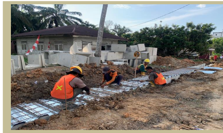
Pek. Penulangan pada Tutup Saluran
