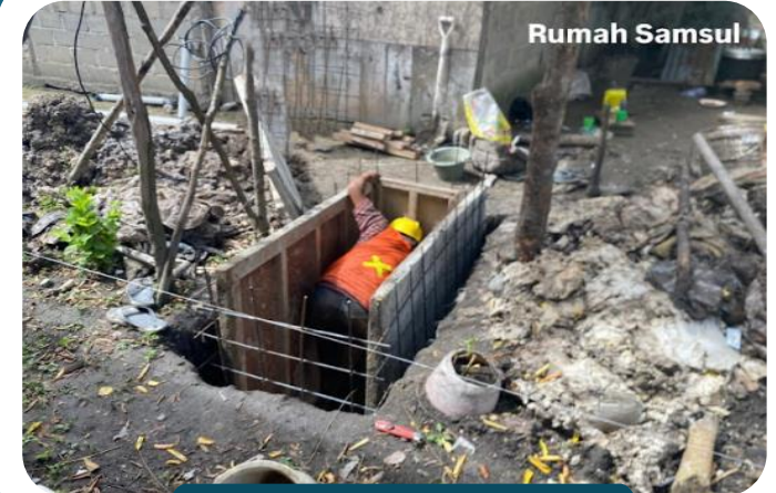
Pek. Bekisting Septictank
