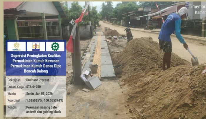
Pek. Pas. Batu Andesit dan Guiding Block STA 0+50 dan 0+250
