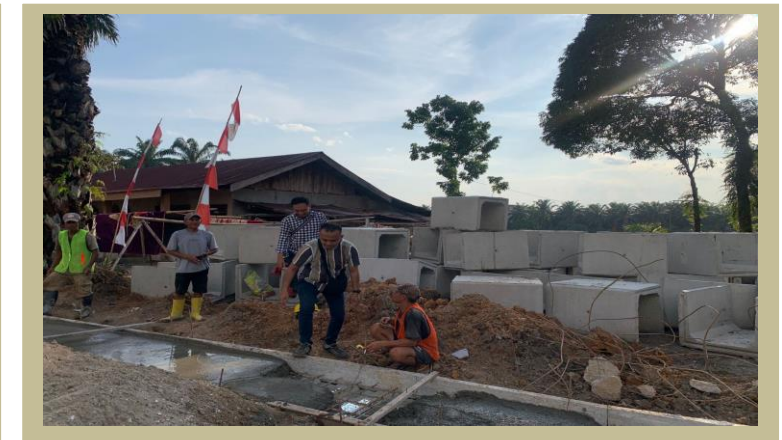
Pek. Pengecoran pada Tutup Saluran
