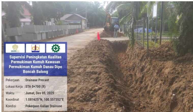
Pekerjaan Galian STA 0+700 (R)
