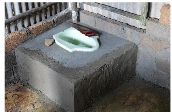
Pekerjaan Pemasangan Closet Leher Angsa
