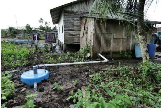
Pekerjaan Pemasangan Pipa Bio-Septictank Rumah Darat
