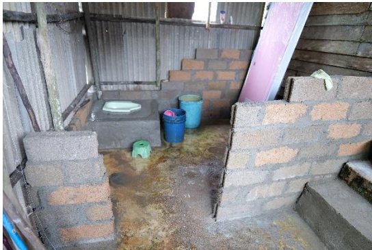
Pekerjaan Pembuatan Bilik Kamar Mandi Rumah Darat
