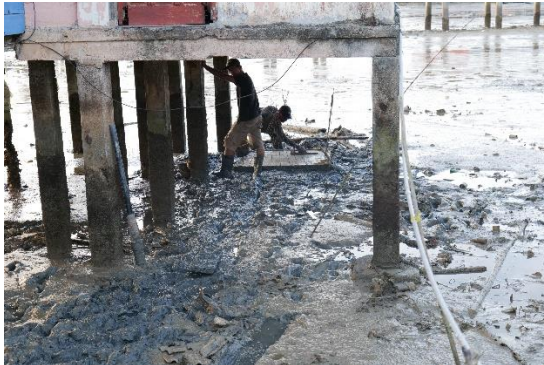
Pekerjaan Cor Pondasi Tapak Bio-Septictank Rumah Laut
