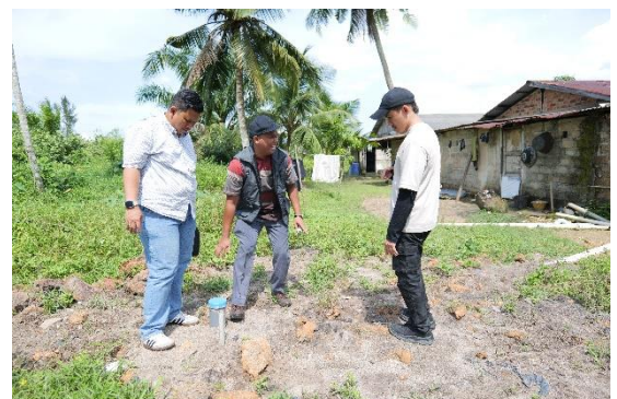
Pekerjaan Pemasangan Bio-Septictank Rumah Darat
