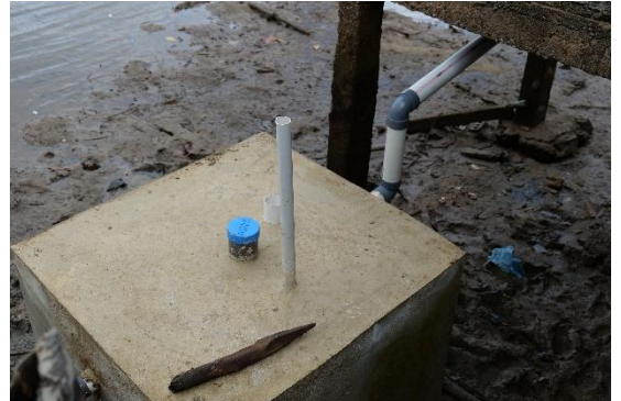
Pekerjaan Pemasangan Pipa Bio-Septictank Rumah Laut
