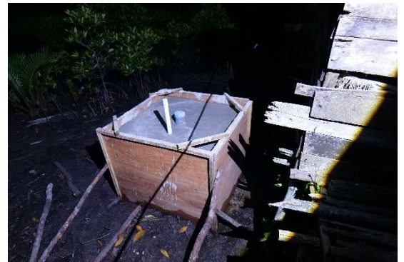
Pekerjaan Pemasangan dan Cor Dinding Bio-Septictank Rumah Laut
