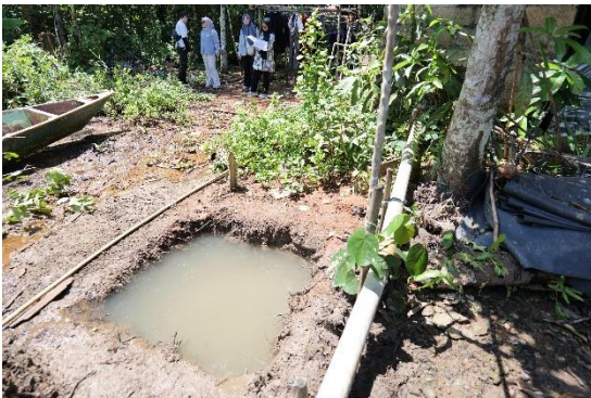
Pekerjaan Galian Bio-Septictank Rumah Darat
