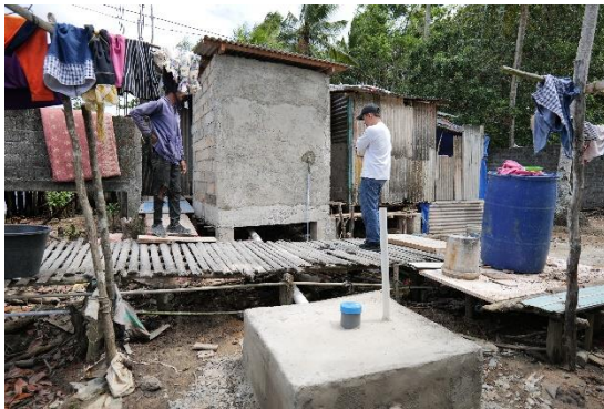
Pekerjaan Pembuatan Bilik Kamar Mandi Rumah Laut
