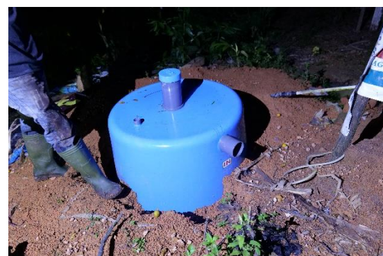
Pekerjaan Pemasangan Bio-Septictank Rumah Darat
