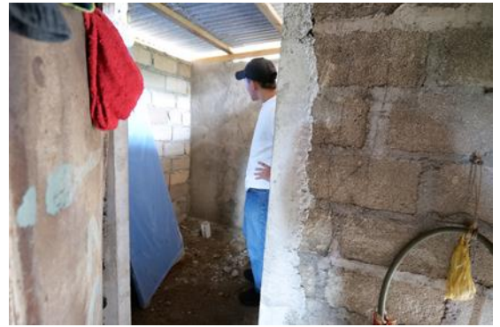
Pekerjaan Pembuatan Bilik Kamar Mandi Rumah Darat
