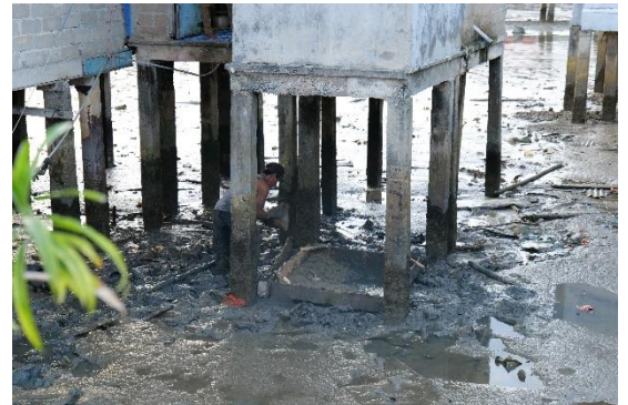
Pekerjaan Cor Pondasi Tapak Bio-Septictank Rumah Laut
