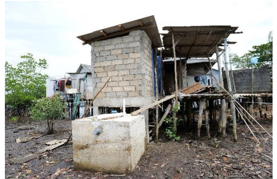
Pekerjaan Pembuatan Bilik Kamar Mandi Rumah Laut
