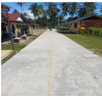
Pekerjaan Jalan Beton
