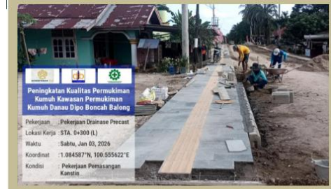
Pekerjaan Pemasangan Kanstin STA 0+300
