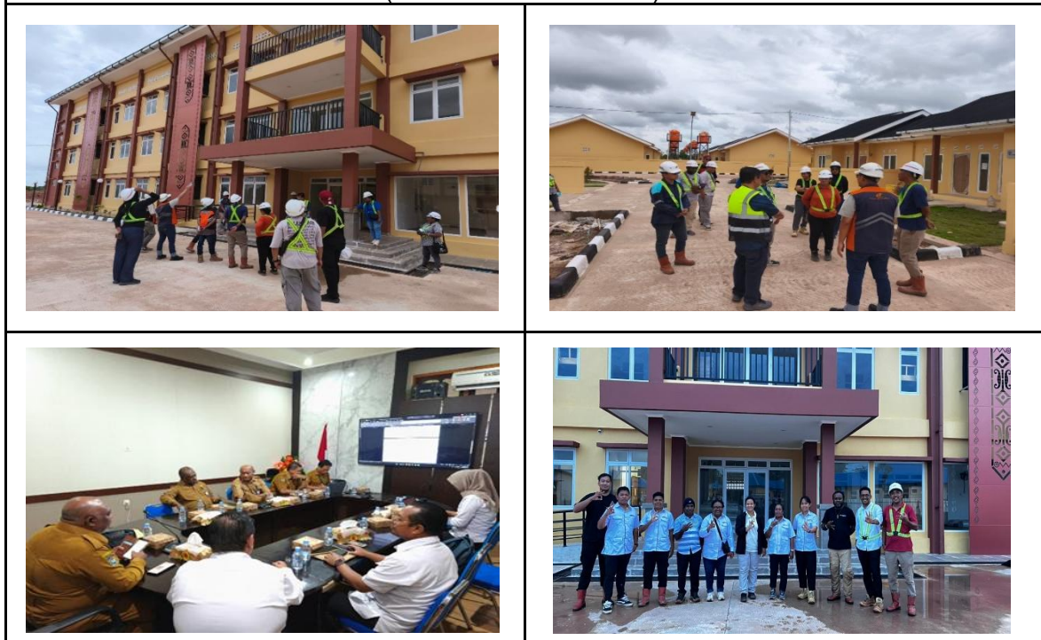
Kegiatan PHO paket pekerjaan Pembangunan Rumah Susun dan Rumah Khusus ASN Pemprov Papua Selatan di Kabupaten Merauke (28-30 Desember 2025)
