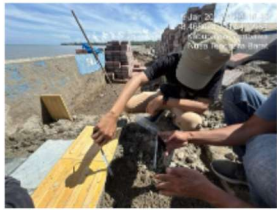
Pemasangan Tactile dan Andesit Jalan Pedestrian
