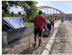
Pekerjaan pemasangan Kanstin Jalan Pedestrian
