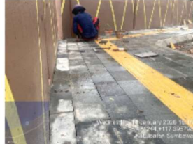
Pengecatan Dinding Pembatas Jalan
