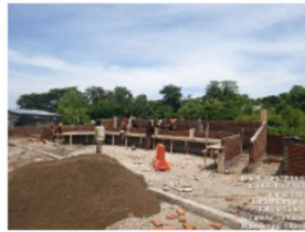
Pekerjaan Taman pada Zona 1
