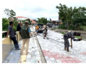
Instalasi Penerangan Jalan Umum
