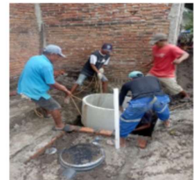
Pekerjaan buis resapan
