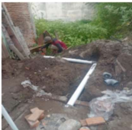
Pemasangan pipa inlet/outlet
