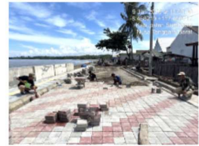
Pemasangan Paving Block
