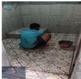
Pemasangan keramik lantai
