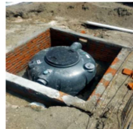
Pemasangan bio-septic tank
