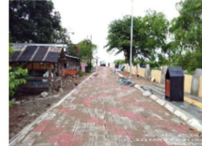
Pemasangan Tempat Sampah dan Penerangan Jalan Umum
