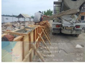
Pekerjaan Pengecoran Dinding Pembatas Jalan
