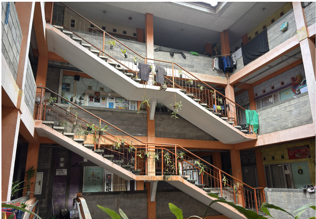
(Area koridor dalam bangunan terlihat asri dengan tanaman gantung)
