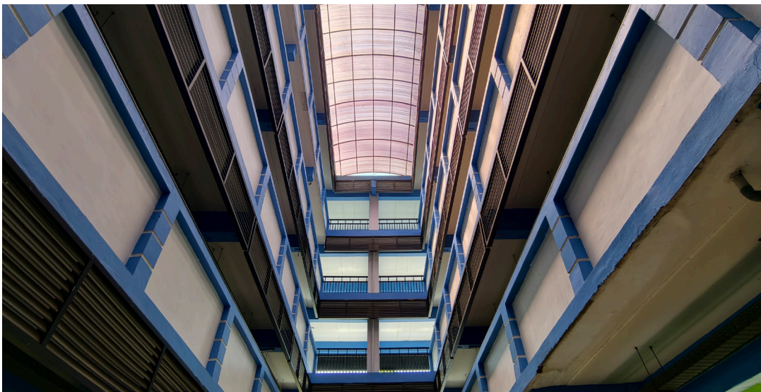
(Rusun memaksimalkan Pencahayaan alami dengan atap transparan di bagian tengah bangunan)
