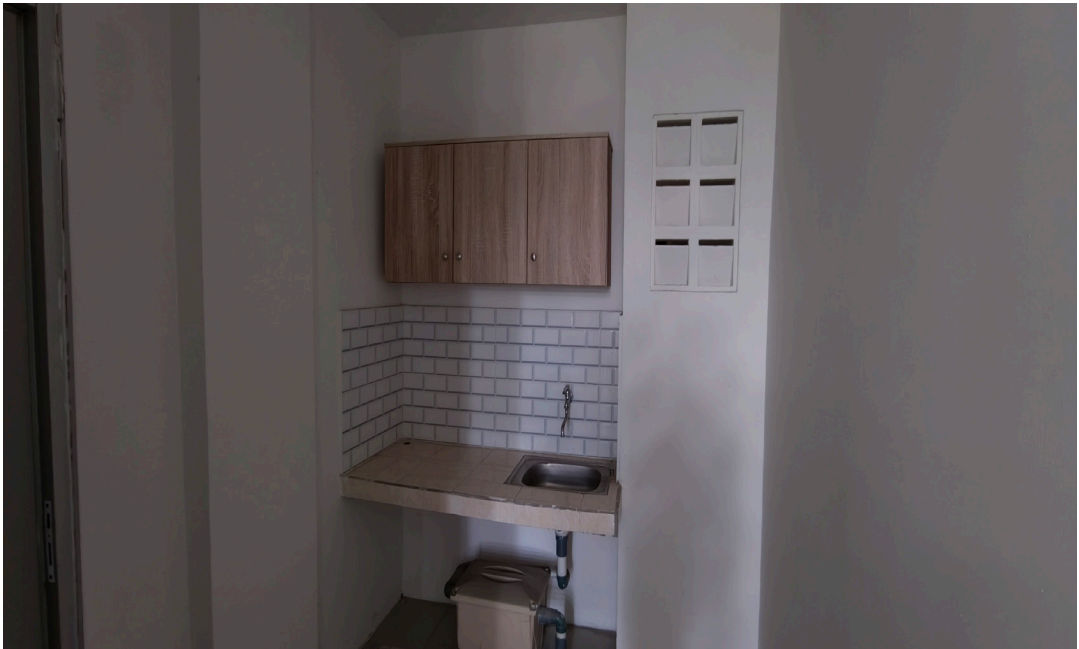
(Wastafel dilapisi dinding keramik agar bersih dan mudah dibersihkan)
