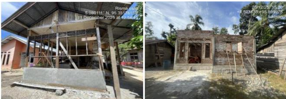
Gambar 3. 29. Pelaksanaan BSPS di Kab. Aceh Jaya
