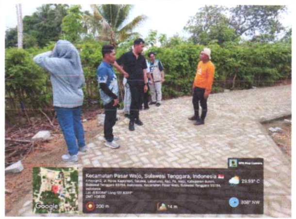
MELAKSANAKAN PEMERIKSAAN PEKERJAAN JALAN PAVING BLOCK
