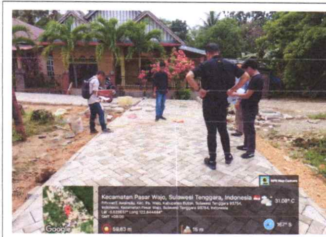
MELAKSANAKAN PEMERIKSAAN PEKERJAAN JALAN PAVING BLOCK
