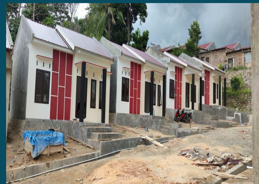
Villa Indah Pondui 2, Kolaka
