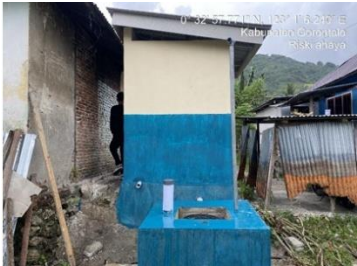
Pek. Pemasangan Bio Septic
