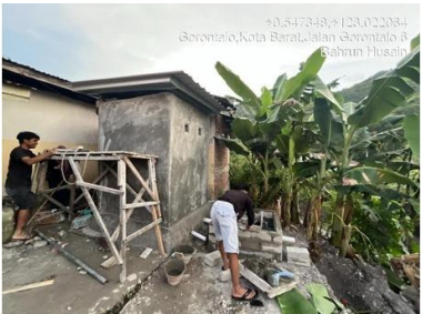
Pek. Pemasangan Bio Septic
