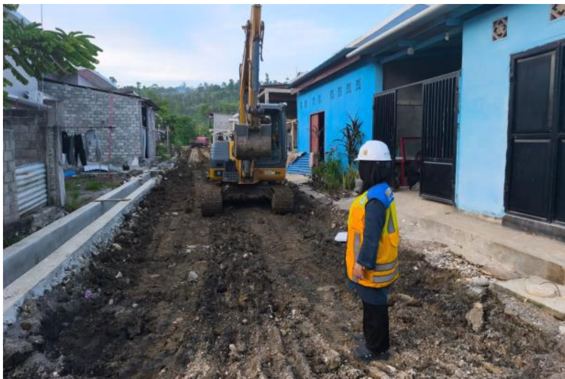
Monitoring Pelaksanaan Pekerjaan Pembangunan Prasarana, Sarana, dan Utilitas (PSU) Rumah Umum MBR di Perumahan Fajar Sowi Damai
