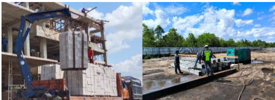
Gambar 3. 13 Persiapan Material dan Alat Kerja Pembangunan Rusun IAKN Palangka Raya
