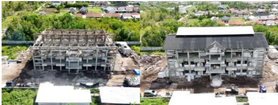
Gambar 3. 19 Progress 50%-75% Pembangunan Rusun IAKN Palangka Raya
