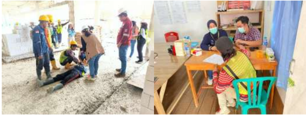
Gambar 3. 14 Induksi Keselamatan dan Kesehatan Kerja (K#) pada Pembangunan Rusun IAKN Palangka Raya
