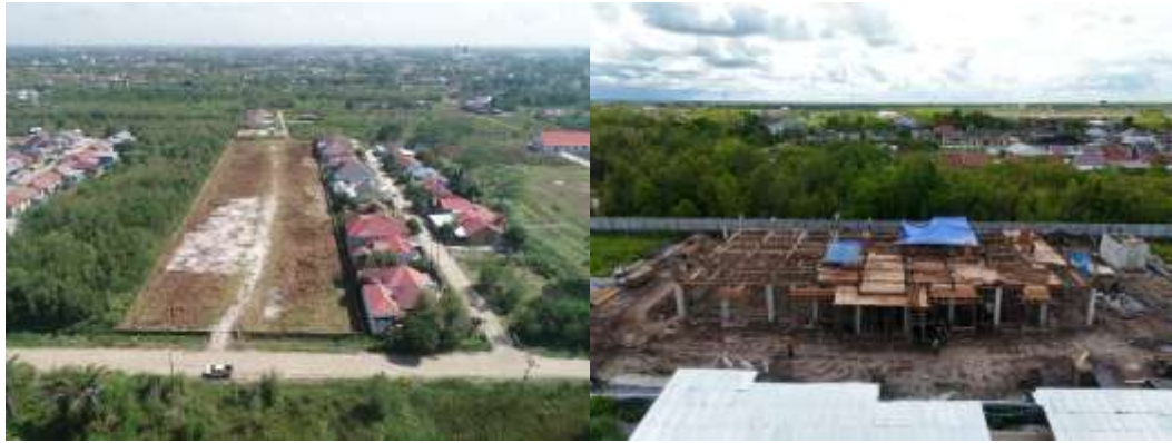
Gambar 3. 18 Progress 0%-25% Pembangunan Rusun IAKN Palangka Raya
