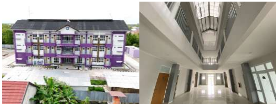
Gambar 3. 20 Progress 100% Pembangunan Rusun IAKN Palangka Raya
