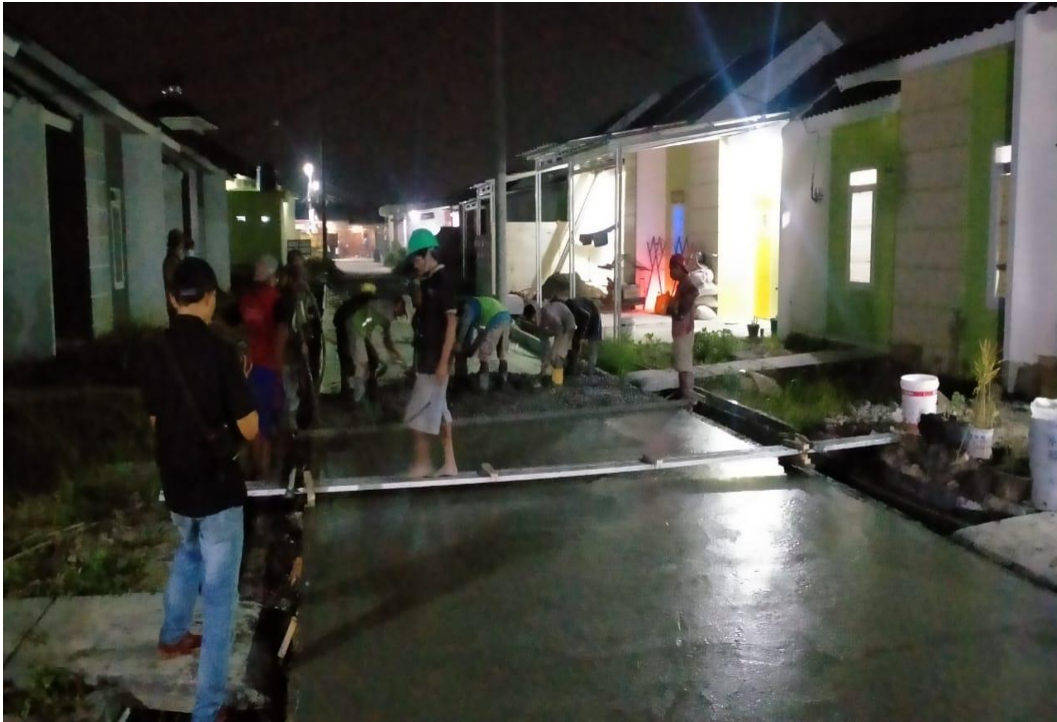
Gambar Kegiatan Pengecoran PSU
